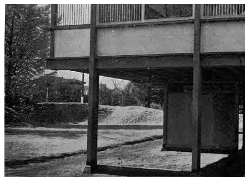
圖11 丹下宅底層挑空與庭院（新建築社編，丹下健三著。〈現在日本において近代建築をいかに理解するか—伝統の創造のために〉。《新建築》。1955，頁20。）
